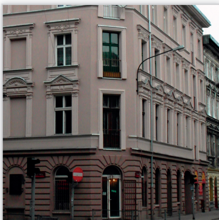
Fasada System, Zabytkowa elewacja. Uzupelnienie gzymсы na elewacji zabytkowej, wykonanie podbitki z płyty MgO (magnezowo-włóknowej).
